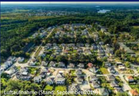
Luftaufnahme (Stand: September 2019)
